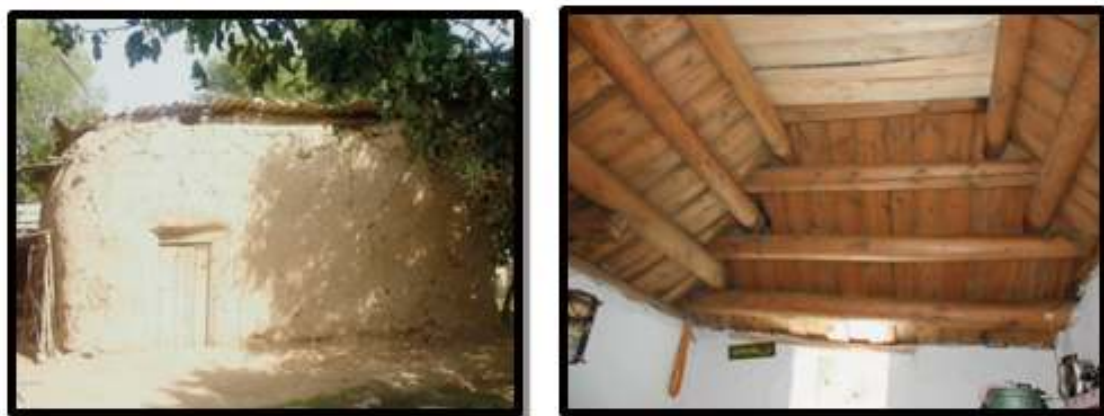
Şəkil 3. Qara dam. Maili formalı ağacdan dam örtüyü. Naxçıvan, Babək rayonu.
